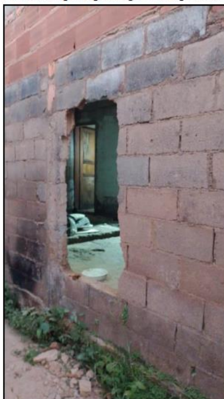
Foto 04: Abertura realizada para passagem temporária dos moradores.
